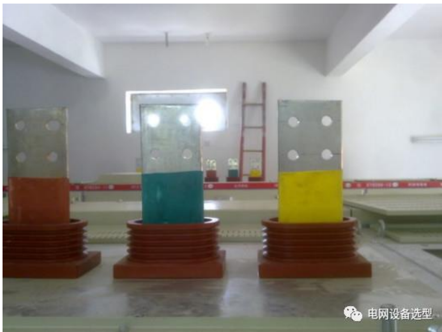
图五：这是母线桥两端，注意相序
