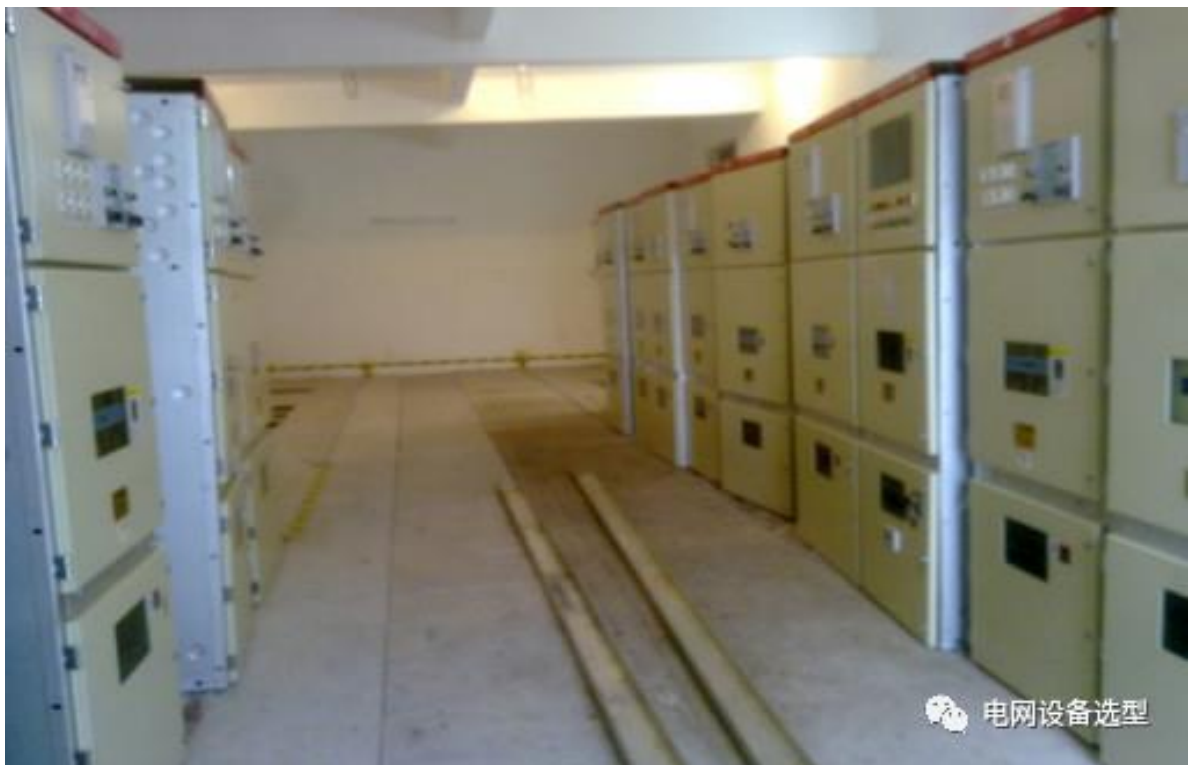
图三：高压柜全部就位后就是这样歪歪斜斜的，注意两排高压柜之间也有槽钢 找准主屏位置，一般是找#1 主变进线柜或#2 主变进线柜为主屏，找齐对正一般以三点一线的方法，即穿墙套管 B 相中心、主屏 B 相进线中心和主屏前
