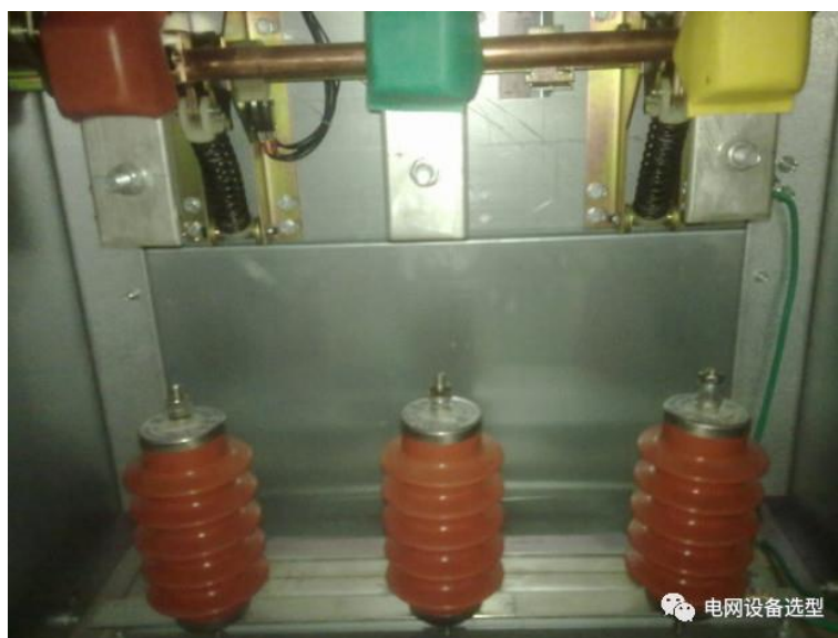
图十三：拆除引线，但是螺丝还是串在螺丝孔上。
