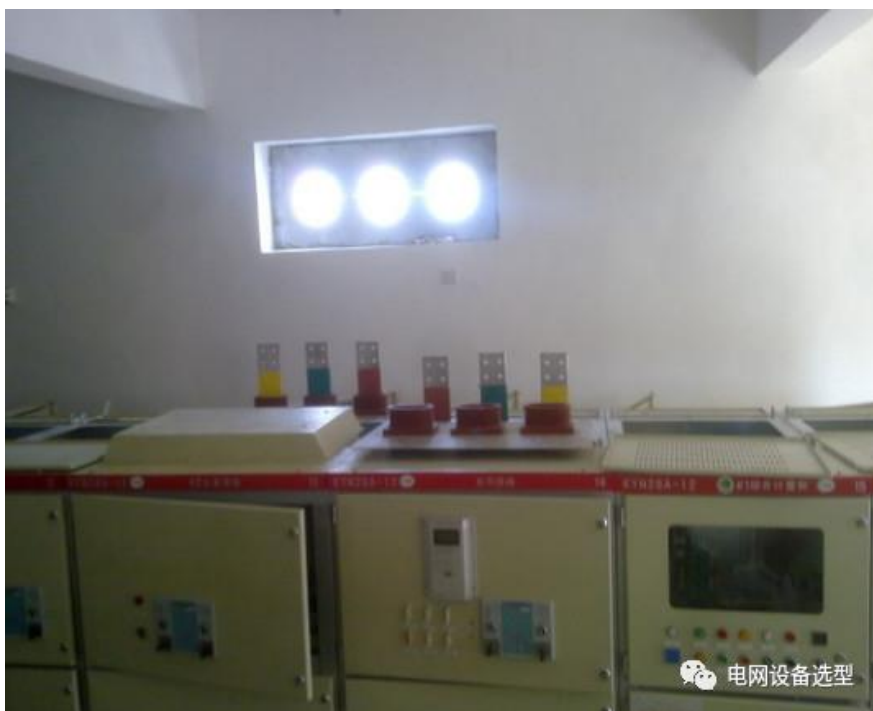
图六:这张图可以看出来反相序了主屏就位后立刻用水平尺打水平,看是否需要垫片垫平,打完水平后立刻电焊固定。
