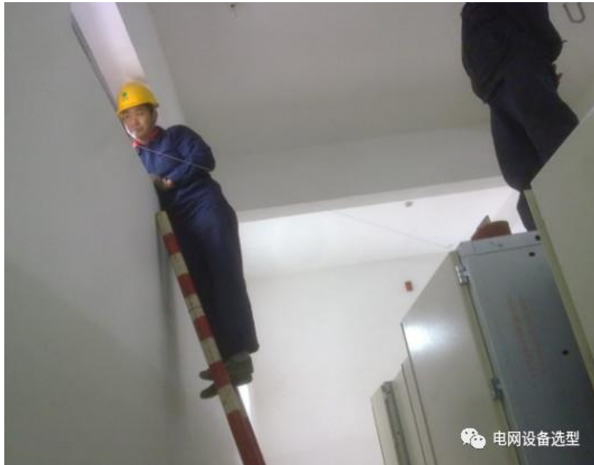
图四：这是在找主屏的中心，位置找准了之后记得打水平。
