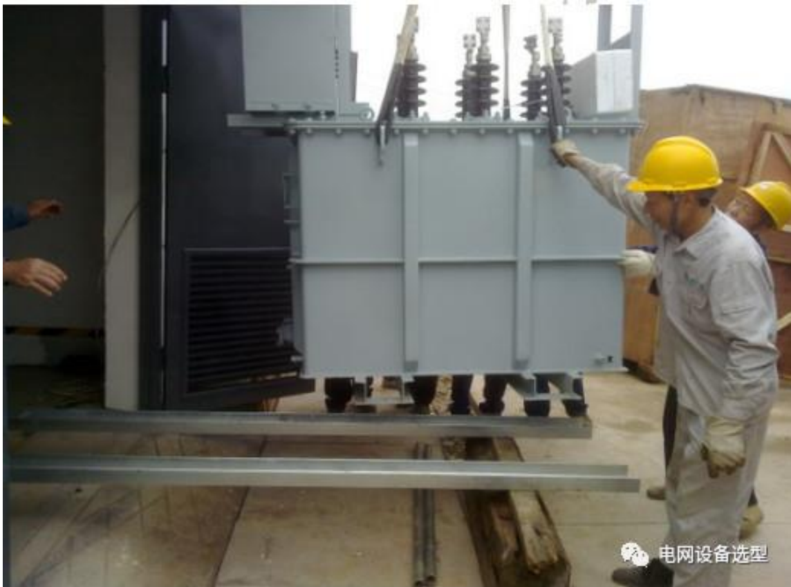
图一：将设备吊装至铺好的平台上(此为电容器)
