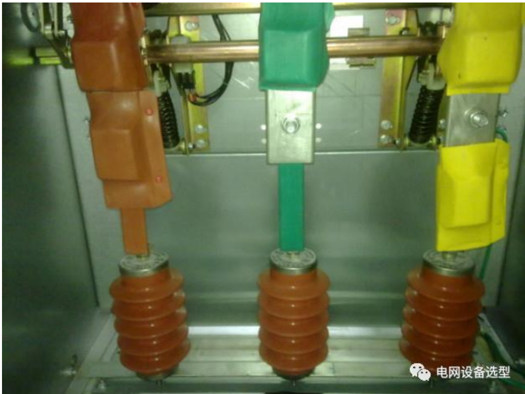
图十二：这个是避雷器及引线，请看清楚接线方式
